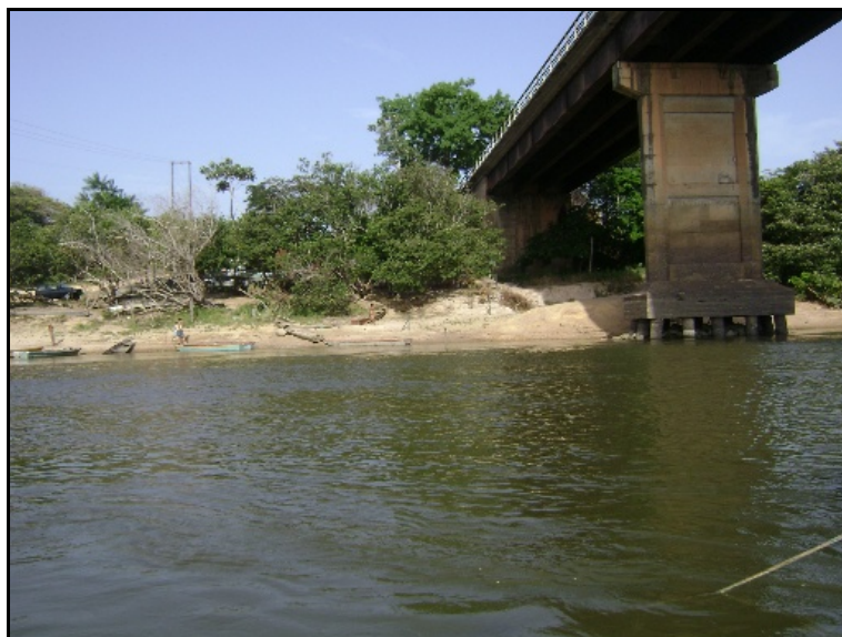
Figura 5.3.2.1-5 – Ponte Sobre o Rio Mucajaí, Ligando Mucajaí a Boa Vista.
