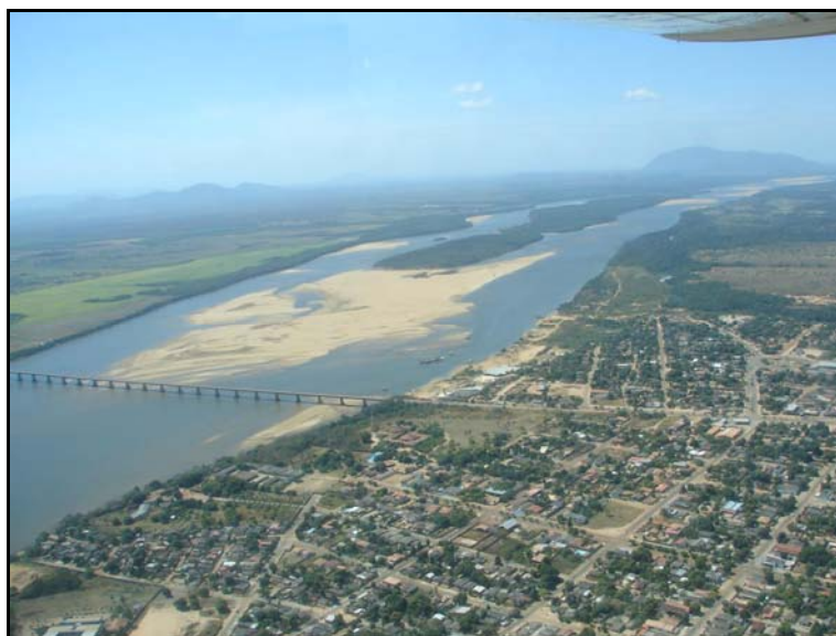
Figura 5.3.2.1-3 – Ponte sobre o Rio Branco: Área Urbana de Boa Vista na Margem Direita e Área Rural de Cantá na Margem Esquerda
