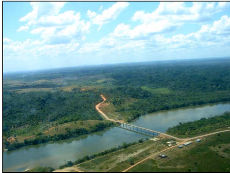
Figura 5.3.2.4-3 – Ponte Sobre o Rio Mucajaí, a Jusante do Local de Barramento do AHE Fé Esperança
