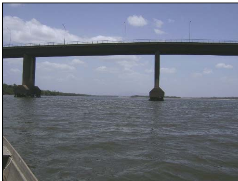
Figura 5.3.2.1-4 – Ponte Sobre o Rio Branco, Ligando Boa Vista à Cantá.
